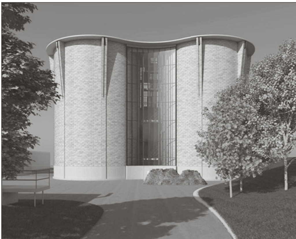
Markantes Zeichen der erneuerten ARA: Die beiden neuen grossen Faultürme.
