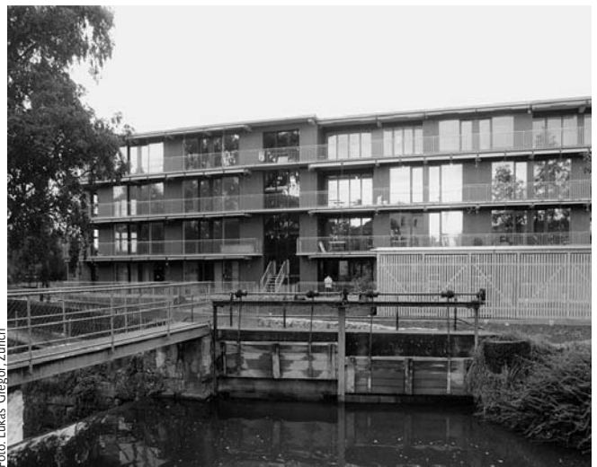
Wohnhaus «Im Lot 1-3», Wilstrasse Michael Alder und Hanspeter Müller, 1998
