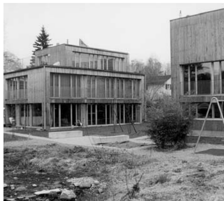
Niedrigenergiehäuser «Living Box», Wagerenstrasse Architeam 4/Holzbausystem Firma RUWA Küblis, 1997
