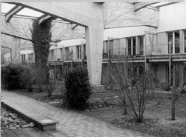
Umnutzung Spinnereigebäude in Wohnanlage «Arche Nova» Guschstrasse, Suter & Suter AG, 1992
