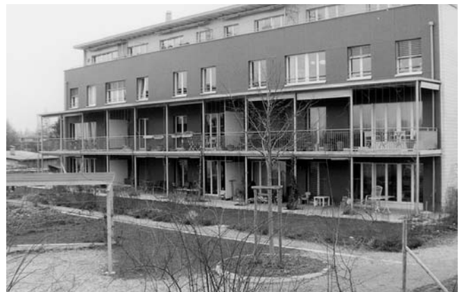
WOGENO-Häuser Talweg, Talweg asa Arbeitsgemeinschaft für Architektur- und Siedlungsplanung 1997
